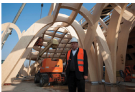
Milan 2015- Pavillon en cours de montage
